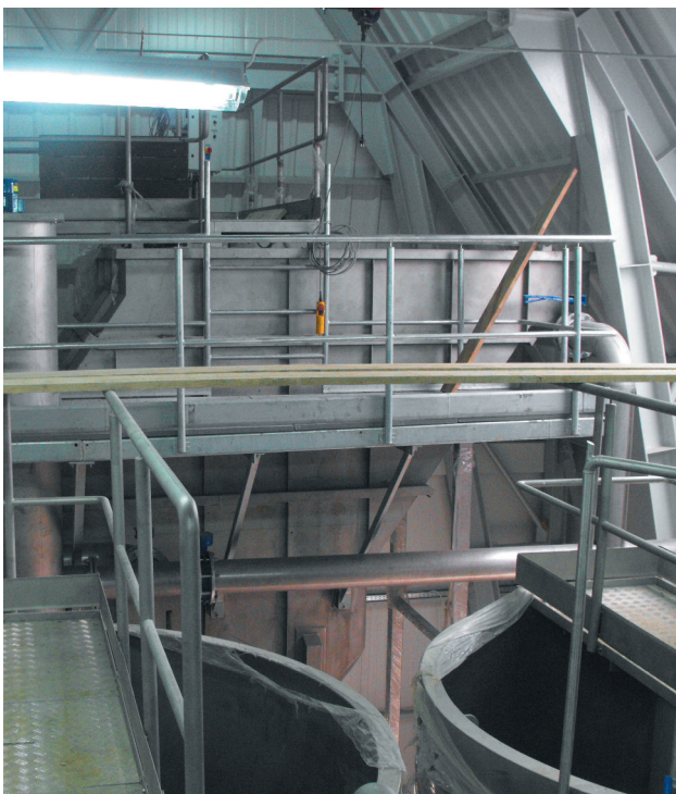
Hala filtrów, w której znajdują się urządzenia do oczyszczania wody
