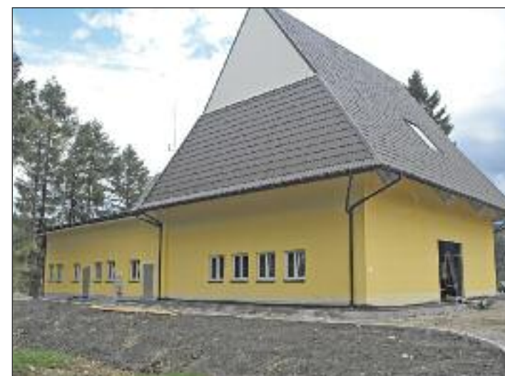
Budynek stacji uzdatniania wody
