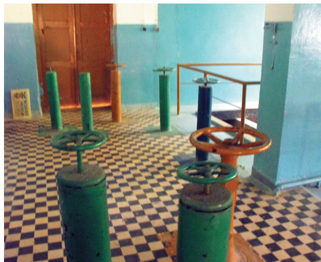
Istniejąca hala zasów
