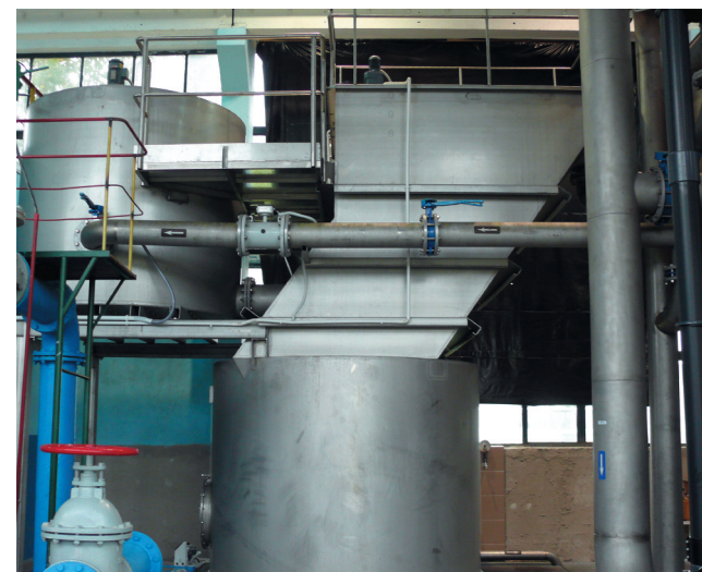
Nowe technologie - filtry pośpieszne, które będą zastosowane na stacji uzdatniania wody
