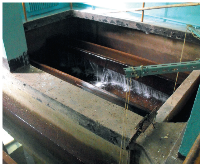
Istniejący filtr pośpieszny na stacji uzdatniania wody
