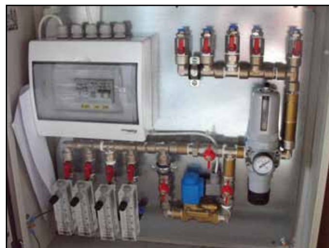
Montowane przepustnice do sterowania przepływem
