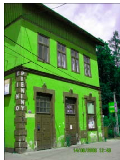
Obecny stan budynku
