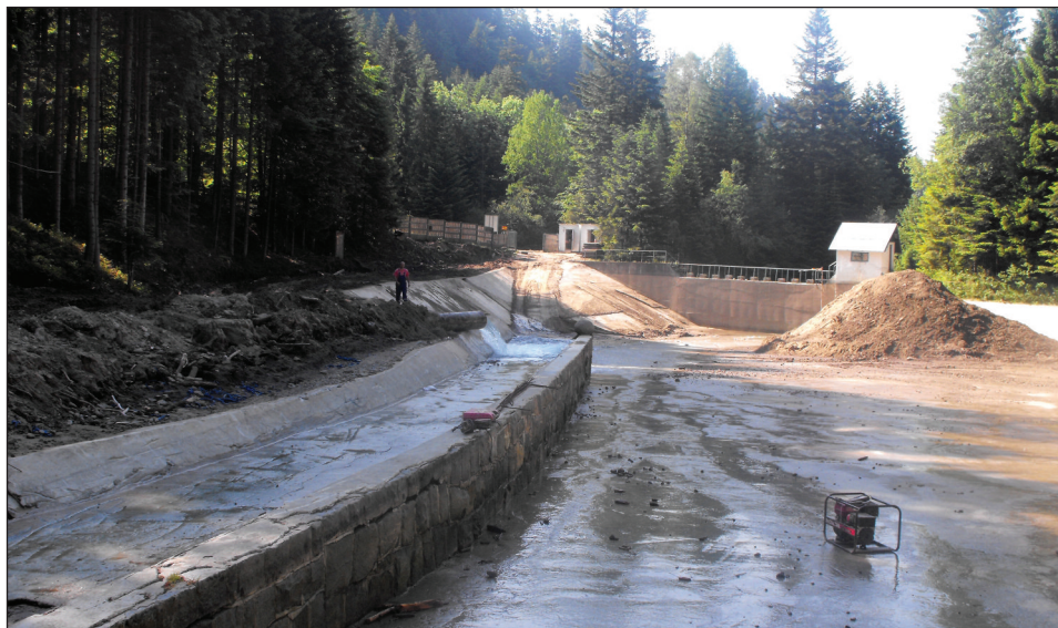
Osuszone ujęcie czekające na remont
