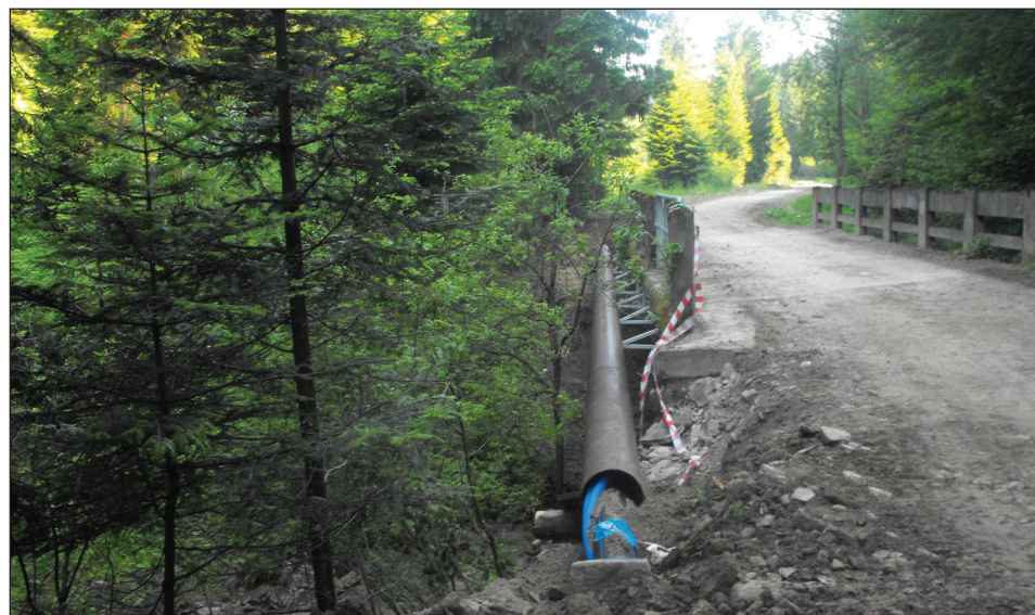
Montowane podwieszenia na mostkach
