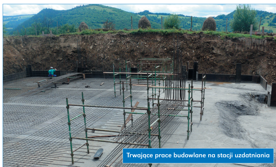
Trwające prace budowlane na ujęciu „Sewerynowka”
