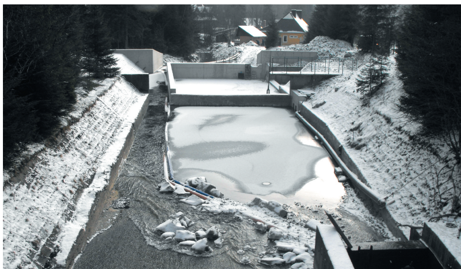
Postęp prac na ujęciu Sewerynowka
