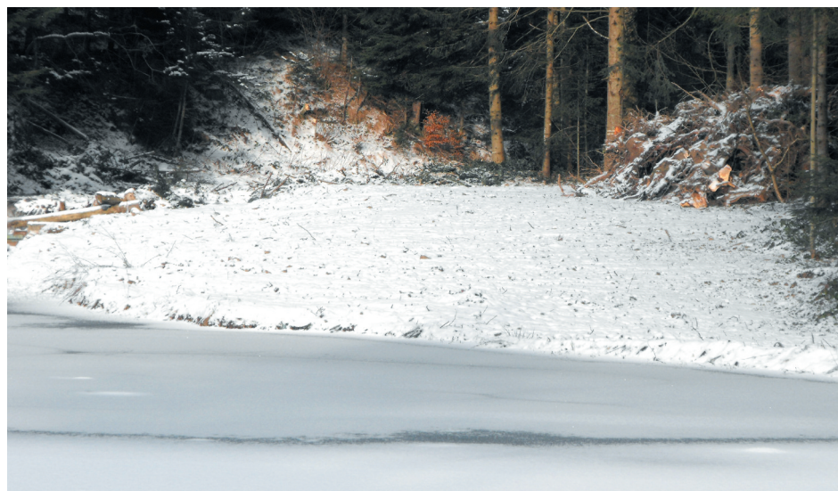
Przygotowany teren do prac na ujęciu wody Pokrzywy
